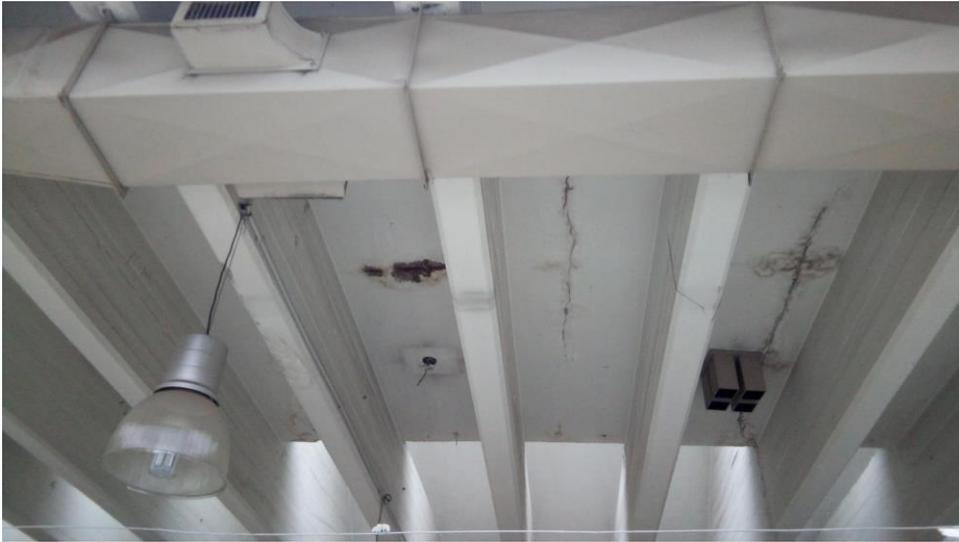
Reparación de losas y pintado de ductos de calefacción
